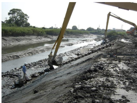
① 施工法面
