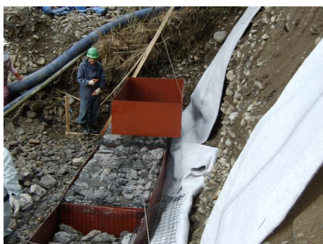
⑤型枠引抜き
