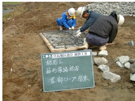
④蓋部結束状況
