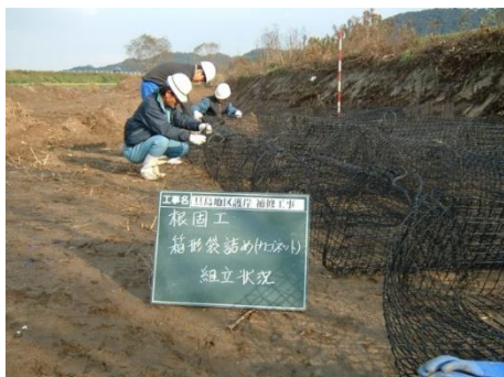
①カゴ組立状況(吊ロープ通し)
