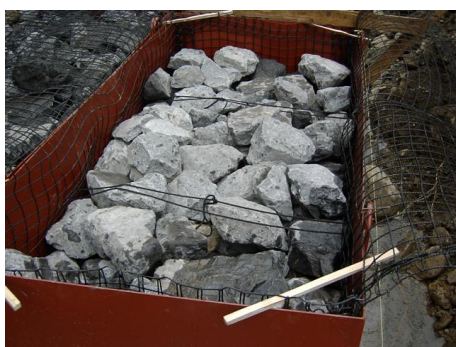
③中詰め材充填及び腹ぶくれ防止ロープ設置
