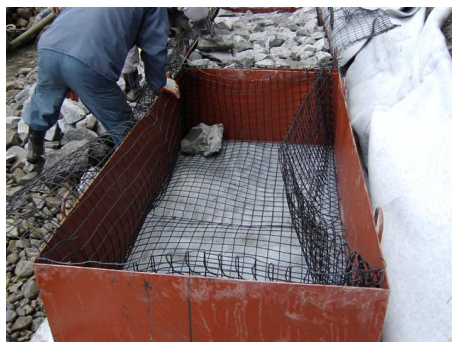
②型枠・カゴ設置
