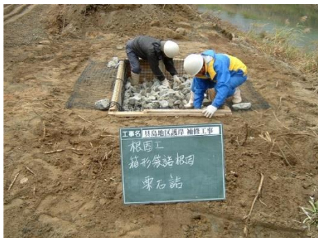
③栗石詰め状況
