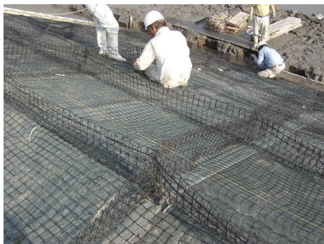
③ 仕切網設置
