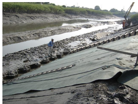
② 吸い出し防止材敷設
