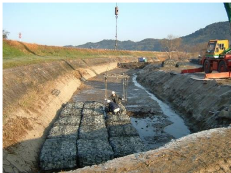
⑤吊り上げ設置状況
