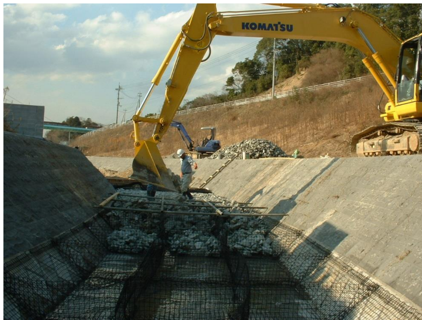
台形断面施工状況
