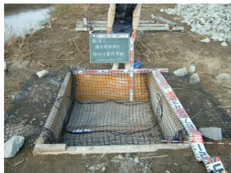
②製作型枠
